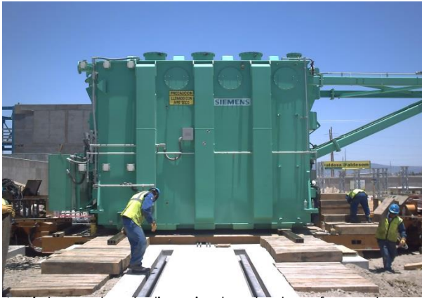
Maniobras de deslizamiento de transformadores para colocarlos a nivel de piso. Dimensiones: 5.80m x 3.22 m x 4.75m @ 98.5 ton.
