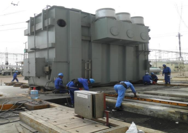
Deslizamiento para la sustitución de transformador en Complejo Termoeléctrica. Dimensiones: 9.60m x 4.70m x 5.10m @ 246 ton.
