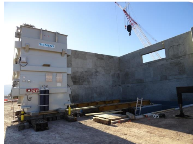
Deslizamiento para el posicionamiento sobre su base de un transformador. Dimensiones: 5.43m x 2.99m x 5.13m @ 120 ton.
