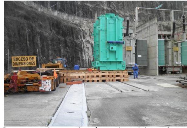
Descarga de un transformador del equipo de transporte a durmientes de madera y posteriormente bajarlo a rieles. Dimensiones: 5.50m x 3.85m x 2.80m @ 70 ton.
